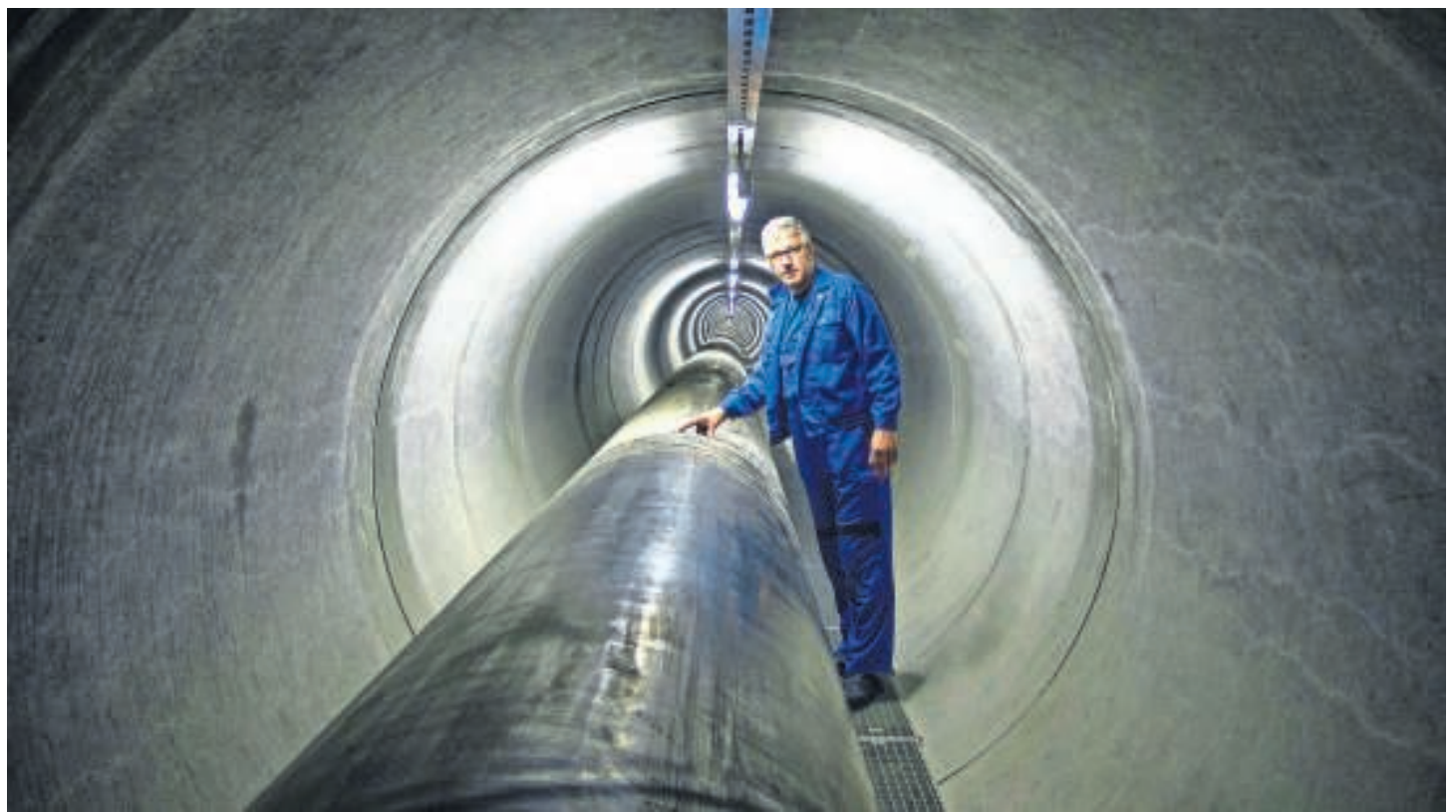
740 Meter lang ist der Tunnel am Kappelberg über Stuttgart: Danach übernimmt die EnBW die Weiterleitung in die Häuser. Fotos: Faltin
